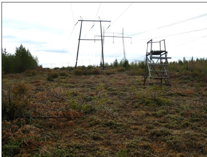
Maarakenteen mäenkumpareen eteläpuolelta pohjoiseen.
